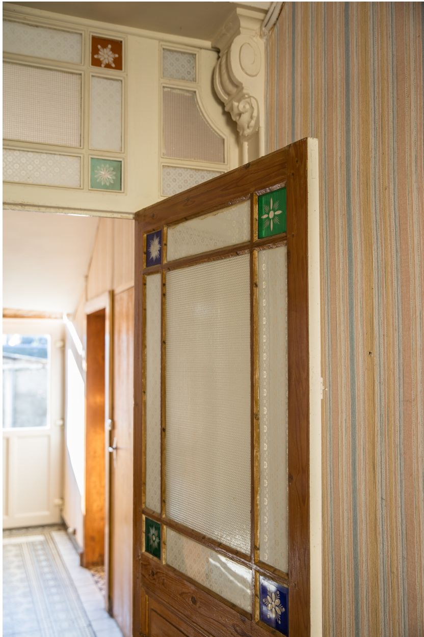
Un détail de la porte-fenêtre.
