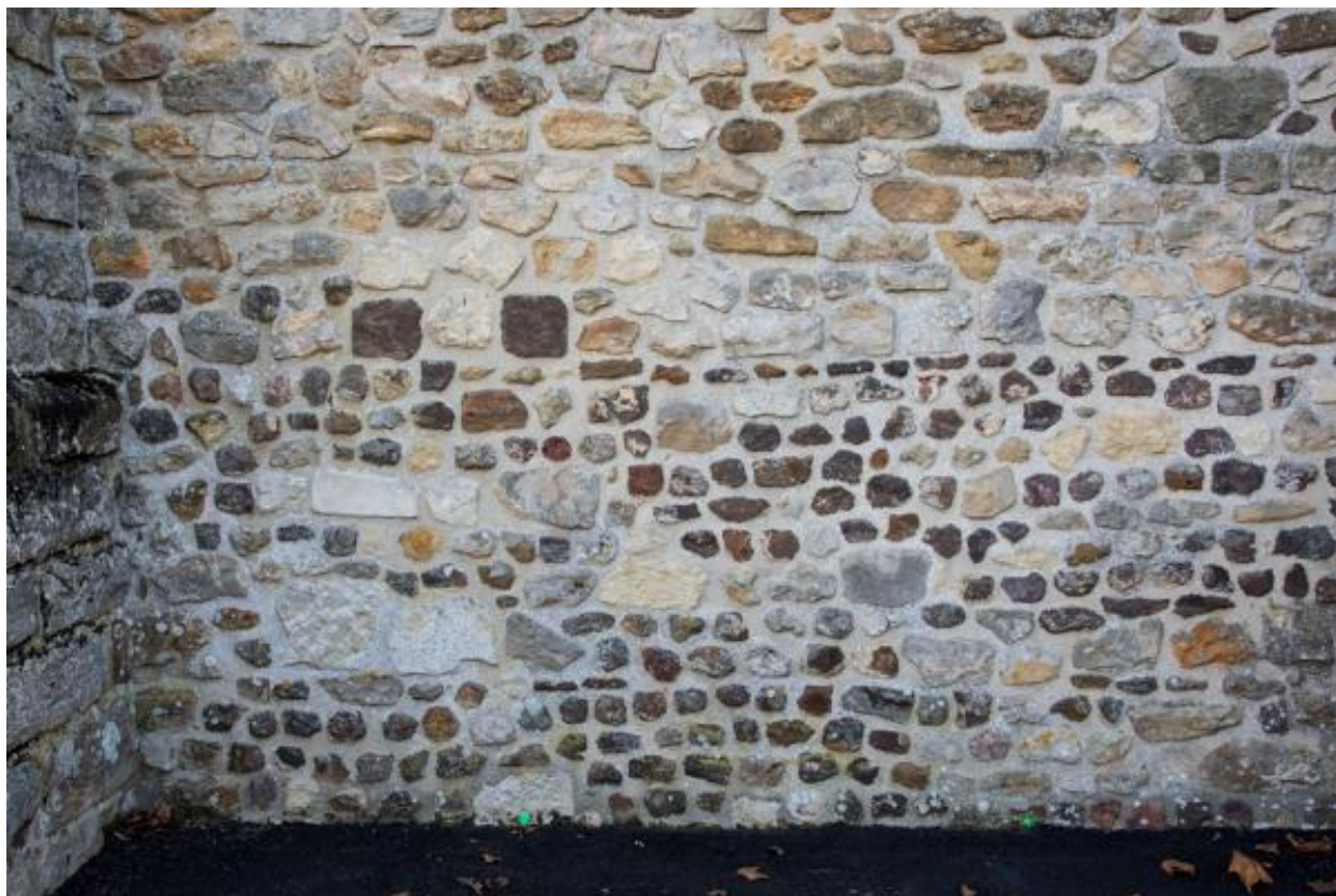
Vue des matériaux au chevet de l'église.
