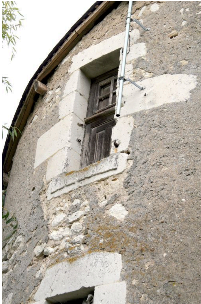
Tourelle, 1er étage : demi-baie.
