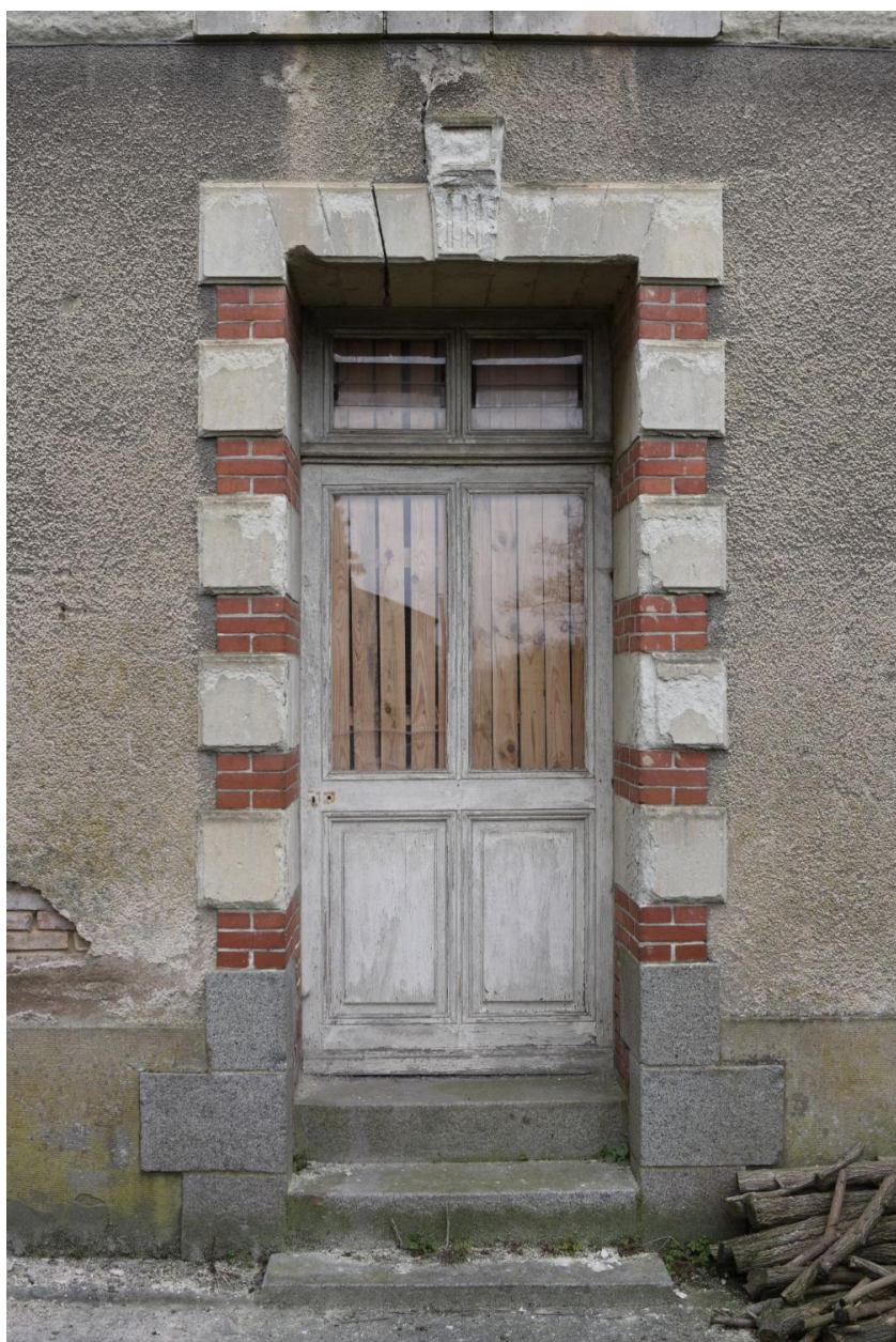
Détail de la porte du bâtiment administratif construit en 1911.
