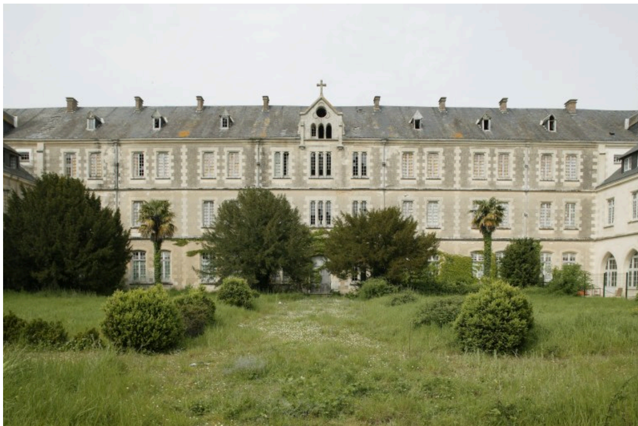
Façade antérieure du bâtiment principal, donnant sur la première cour.
