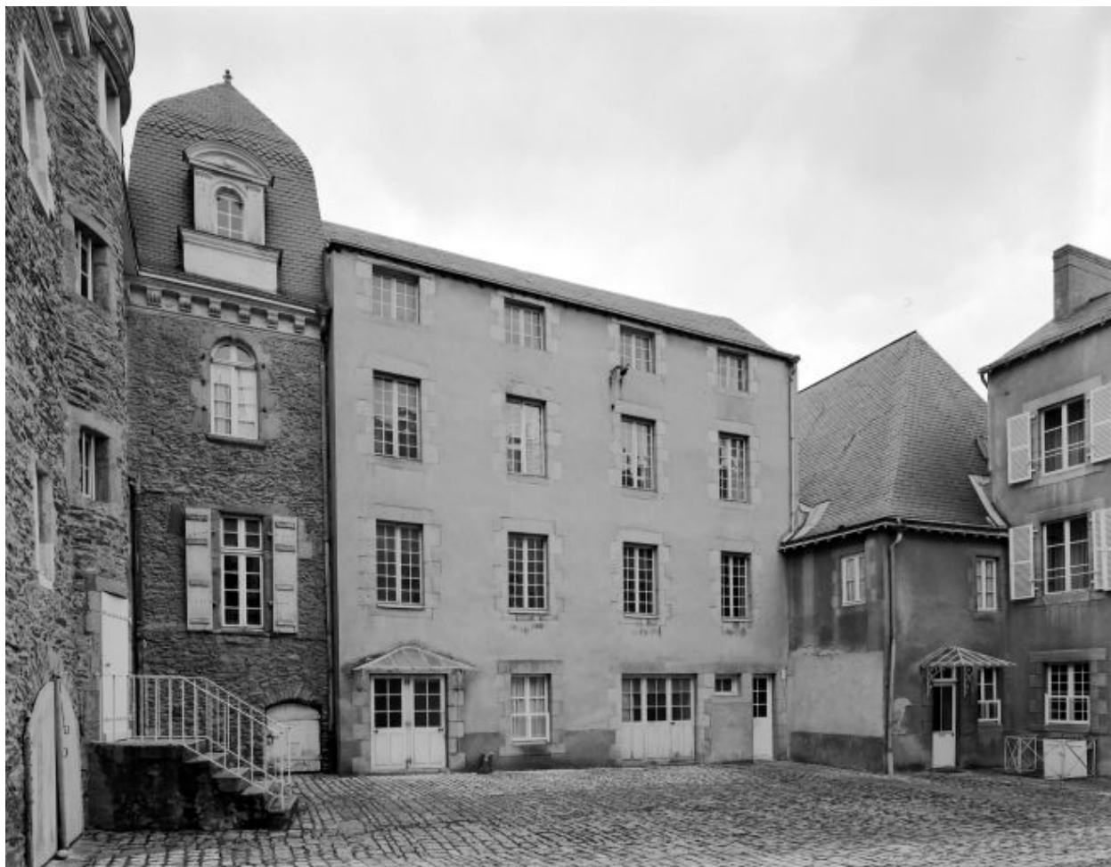
Cour d'entrée, élévation du bâtiment latéral sud.
