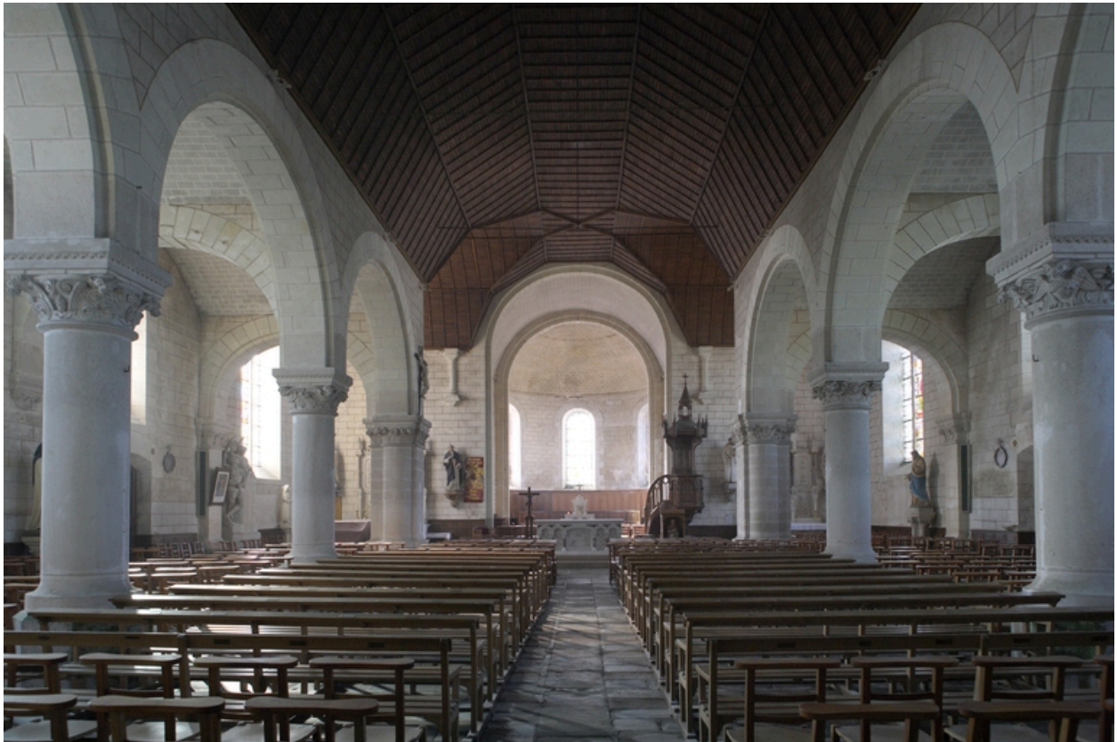
Vue de l'intérieur depuis l'entrée.
