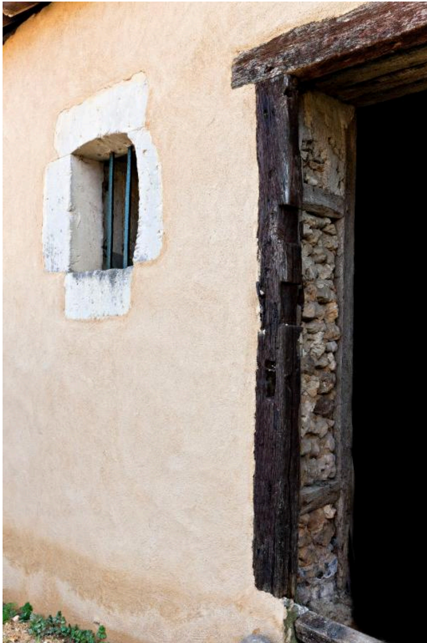
Dépendances après restauration : détail d'une entrée.
