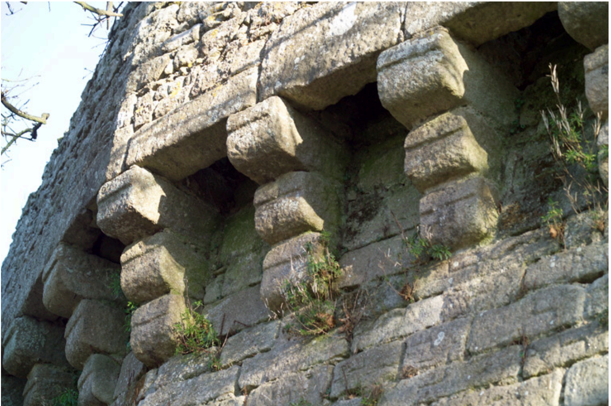
Détail des consoles portant le chemin de ronde.
