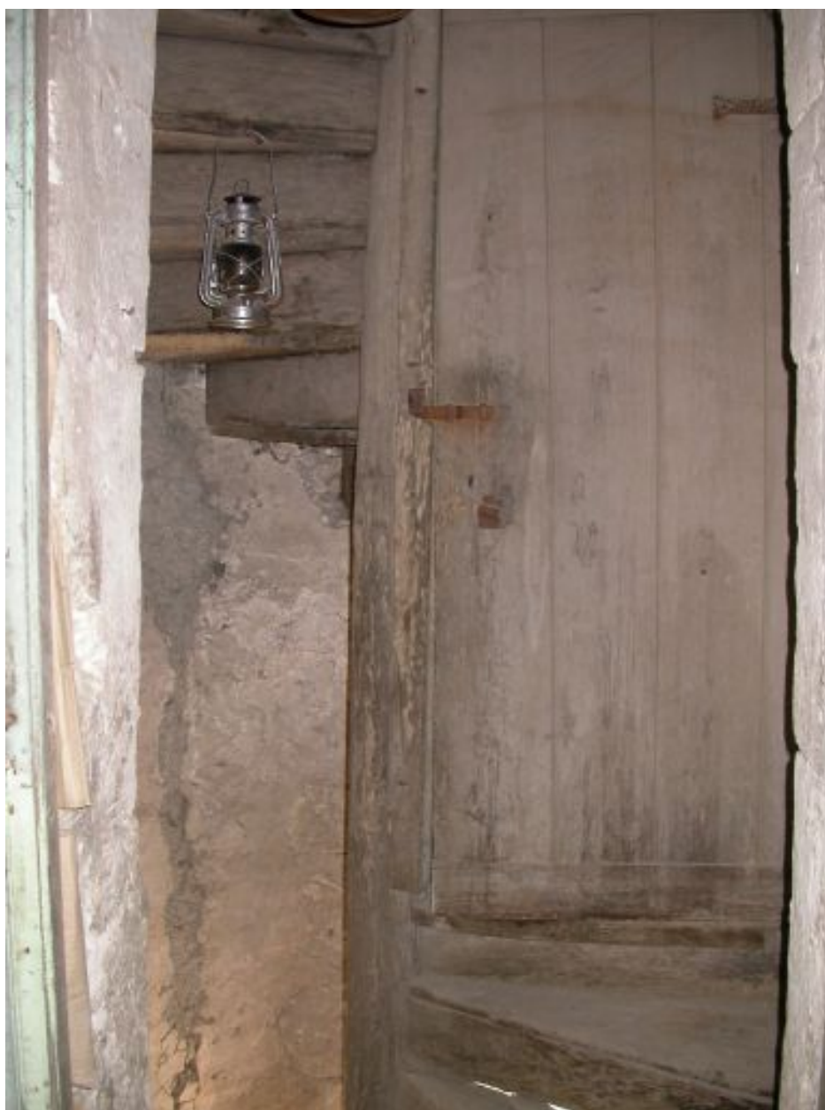
Palier du rez-de-chaussée surélevé : porte pour l'accès au grenier.
