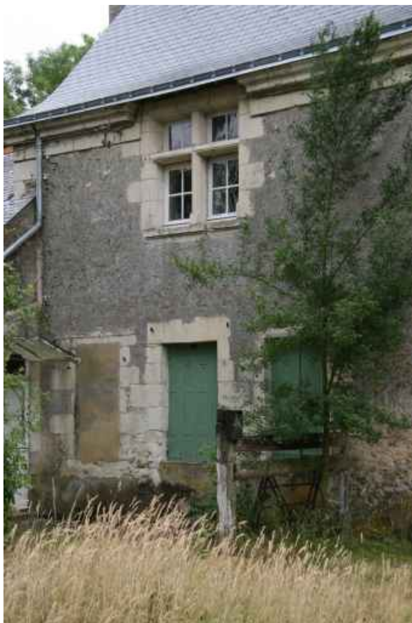
Aile ancienne : troisième travée de baies.
