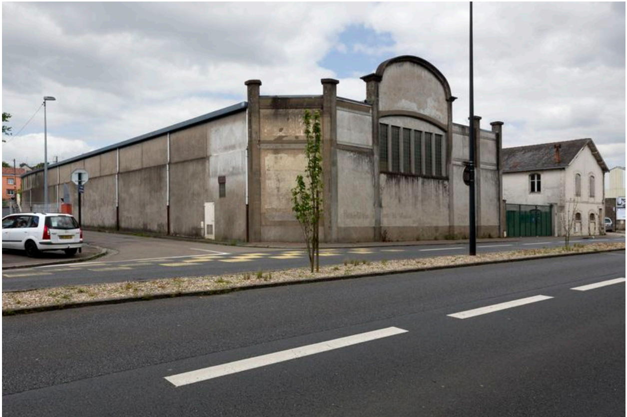
Façades donnant sur le boulevard du Maréchal Juin, côté ouest.
