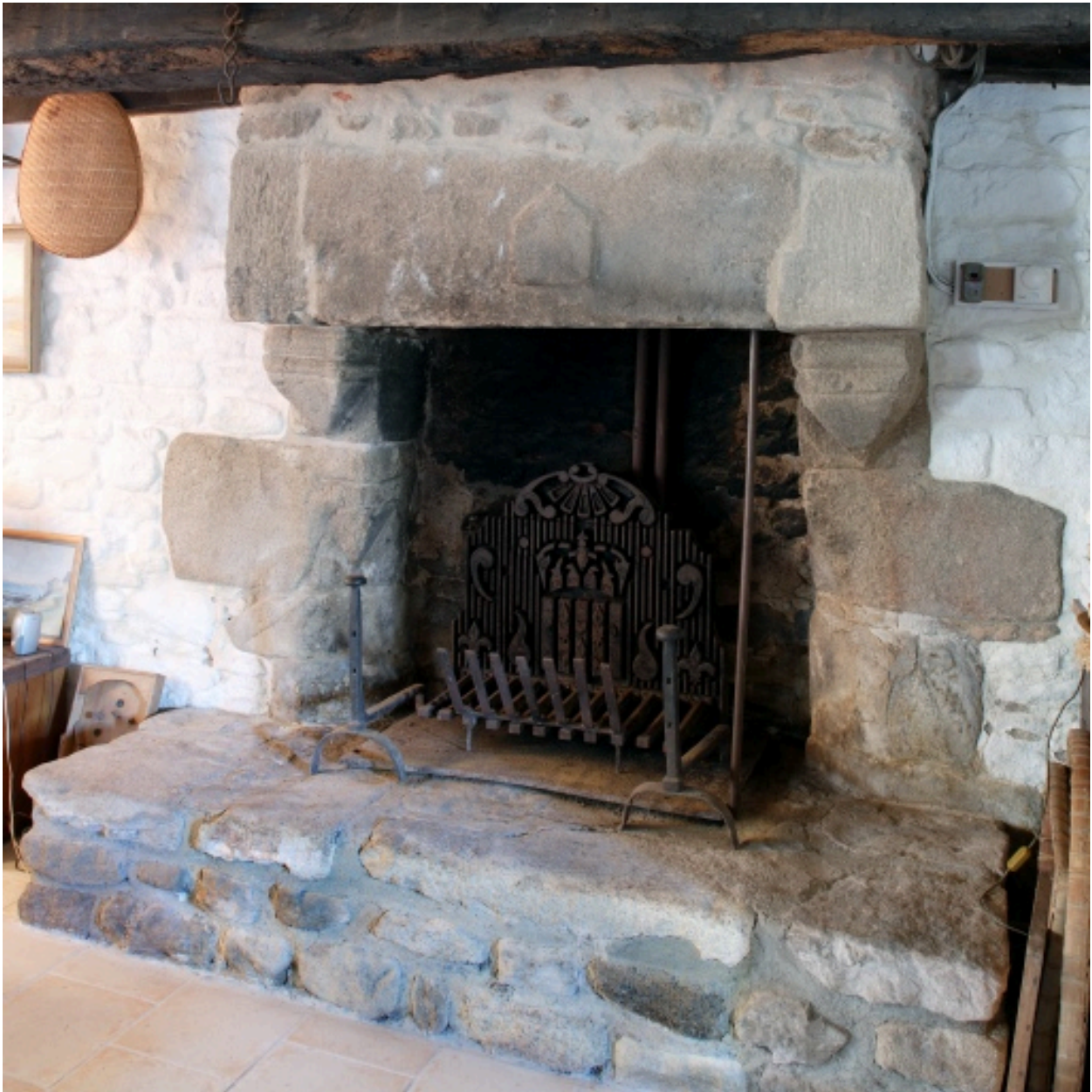
Vue de la cheminée du rez-de-chaussée du logis est.
