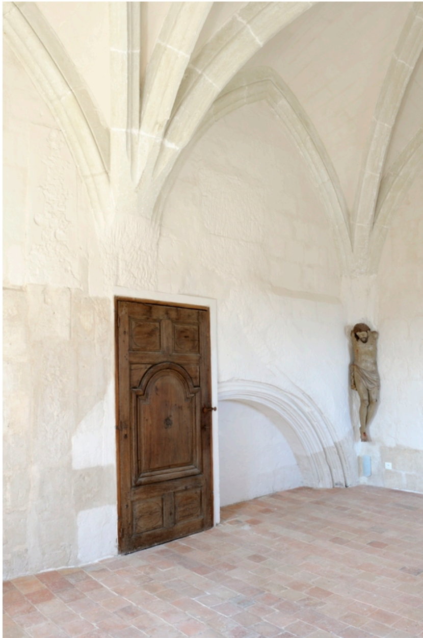
Ancienne chapelle nord (fin XVe siècle), étage, mur sud. Voûtes et ancienne grande arcade à décor flamboyant bûché.
