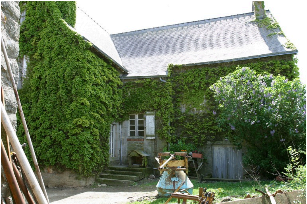
Le logis vu depuis le nord-ouest : la façade arrière du corps de bâtiment principal et l'aile.
