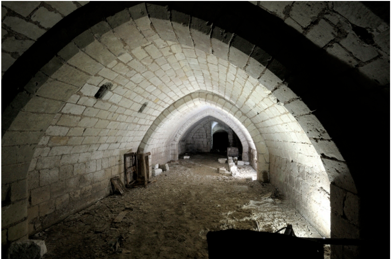
Cave creusée dans le mur de contrescarpe des douves, couverte d'une voûte brisée à doubleaux chanfreinés
