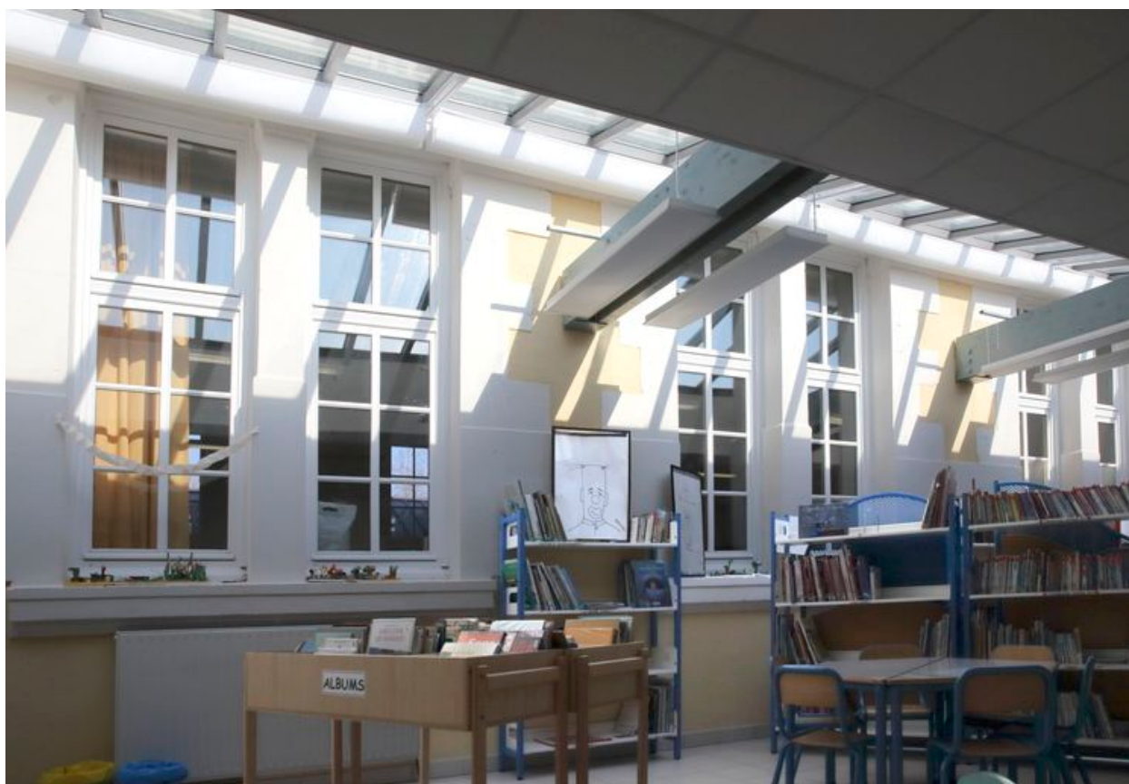
Ancien mur de façade de l'école des garçons, aujourd'hui bibliothèque.
