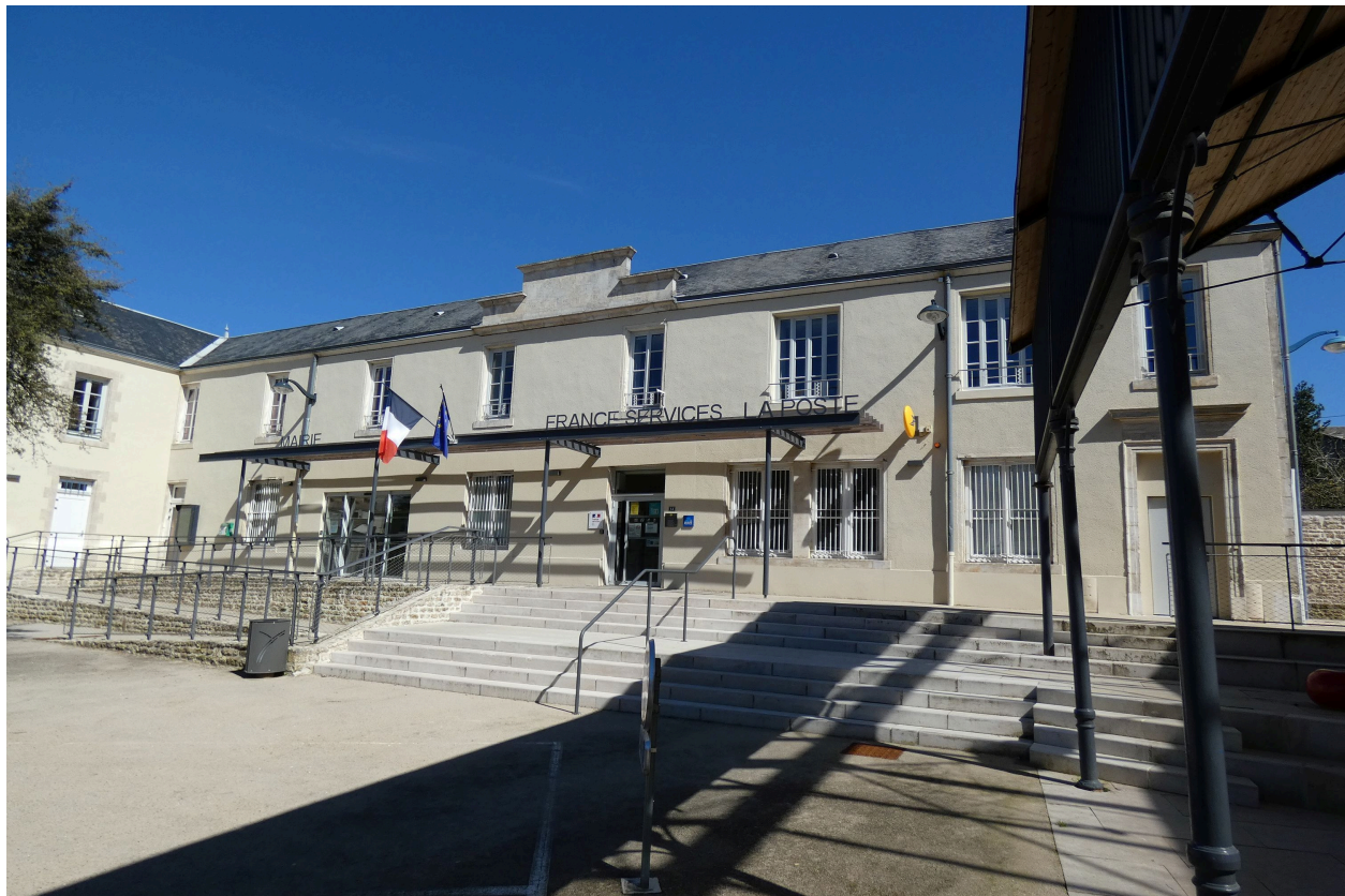
L'ancien bâtiment de classes vu depuis l'ouest.
