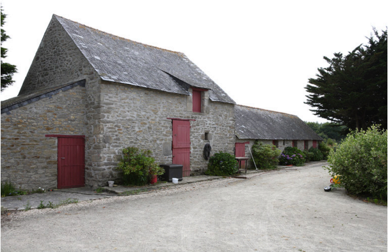
Écurie et porcherie. Façade nord.
