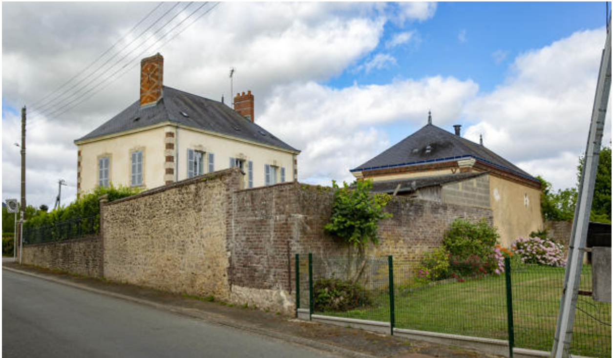
La façade postérieure et la dépendance.
