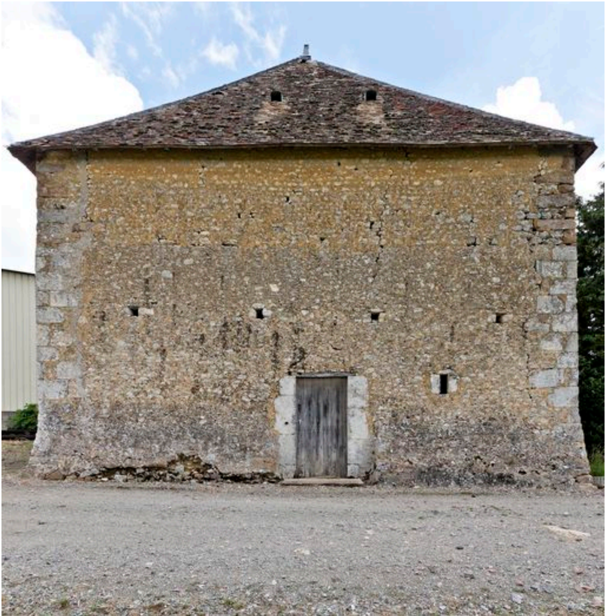
Mur-pignon gauche de la grange-étable-fenil
