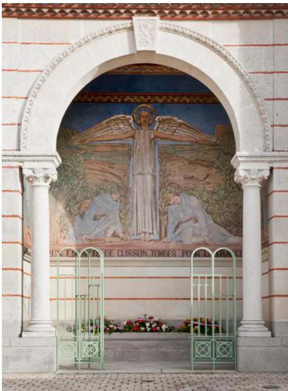
Monument aux morts : vue d'ensemble.
