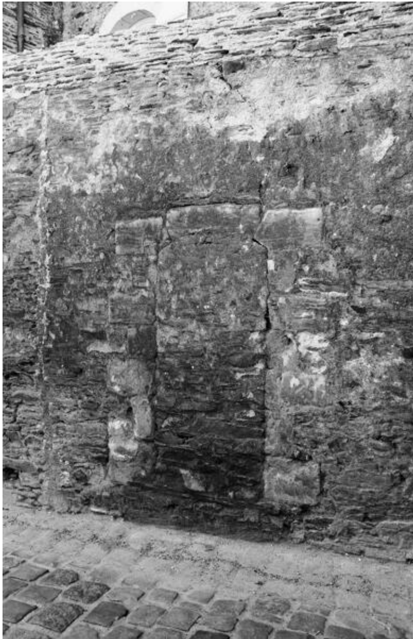
Mur de clôture le long du bâtiment conventuel, sur la rue des Augustins : détail sur la porte.
