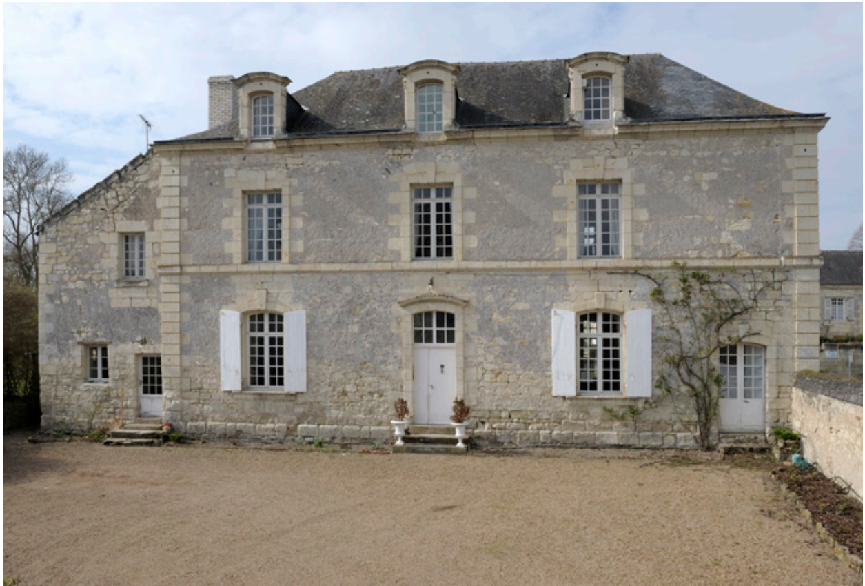
Façade sur cour.
