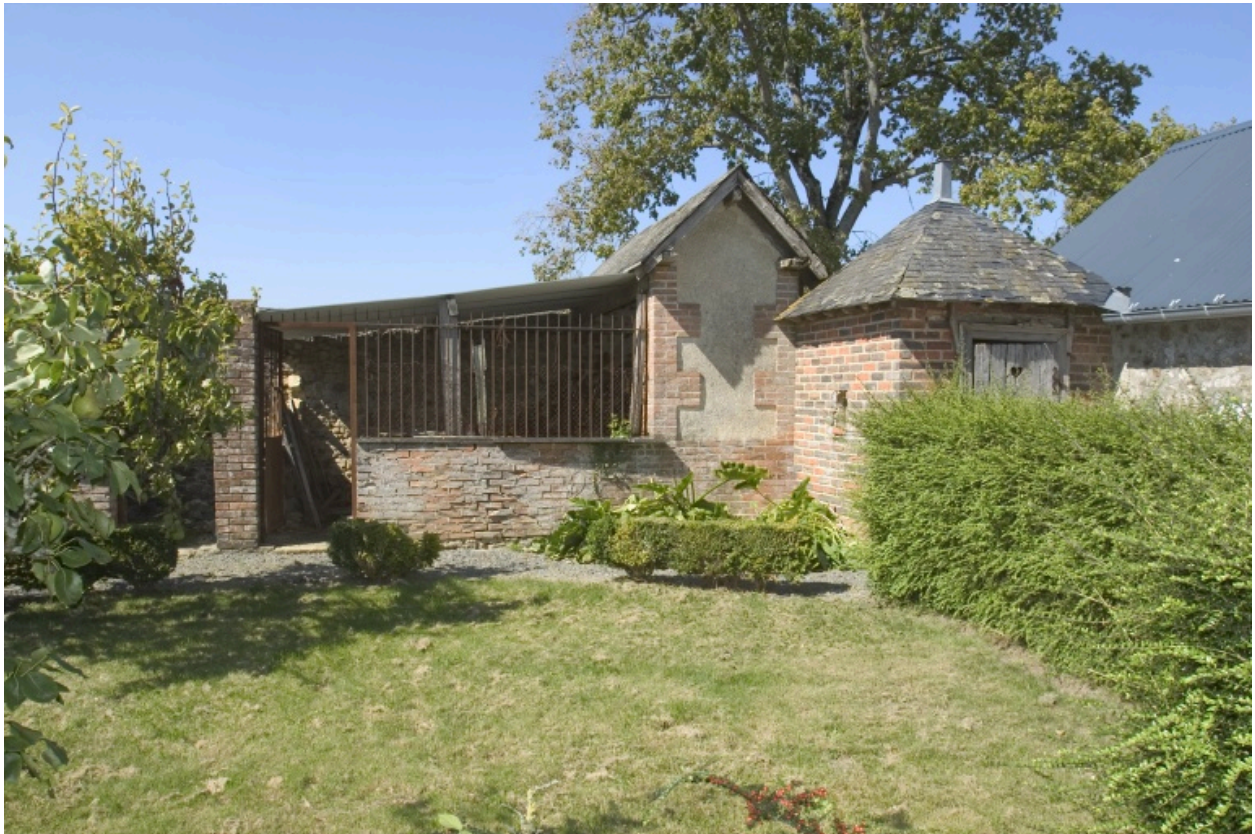
Le chenil (?) et les latrines vus depuis le sud-est.
