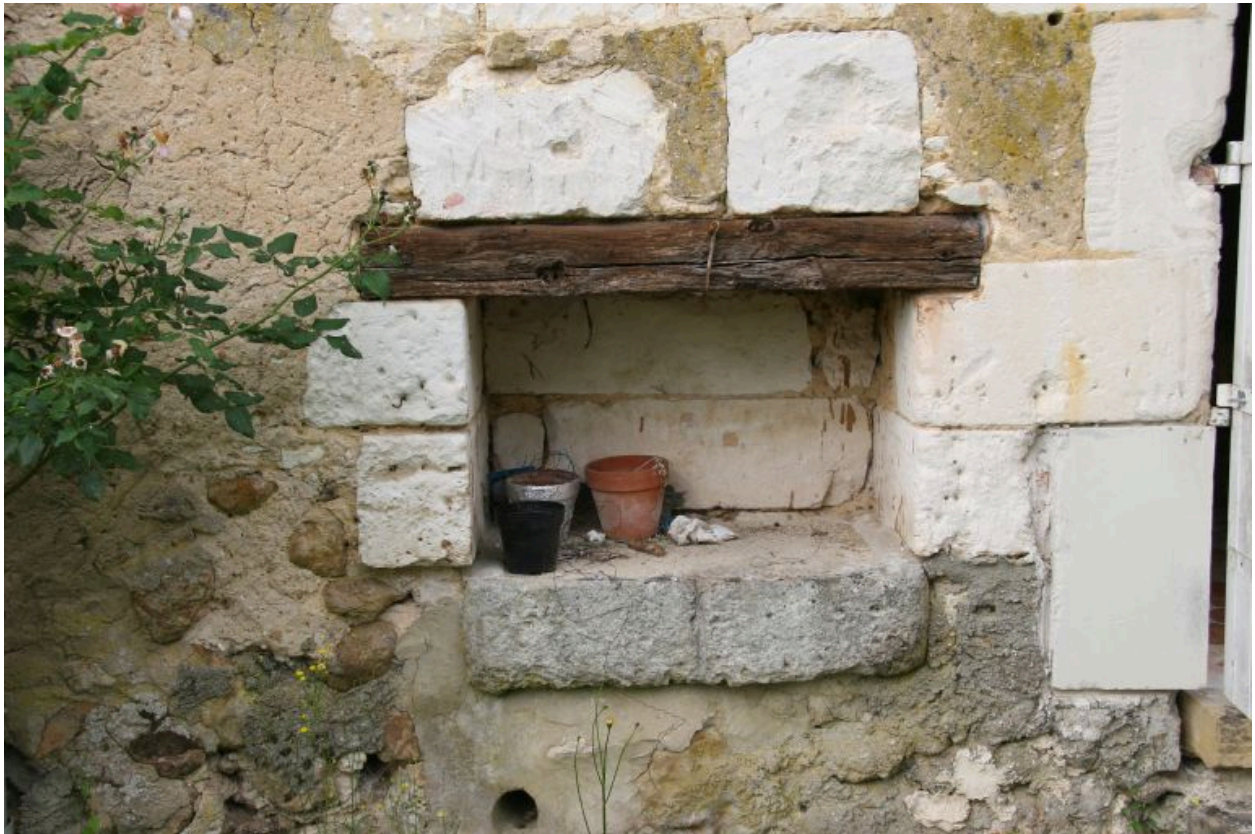
La maison, détail : niche ouverte vers l'extérieur.
