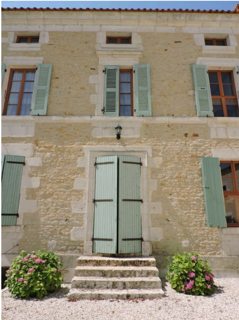
Détail de la façade nord-est, côté cour, et de son décor.
