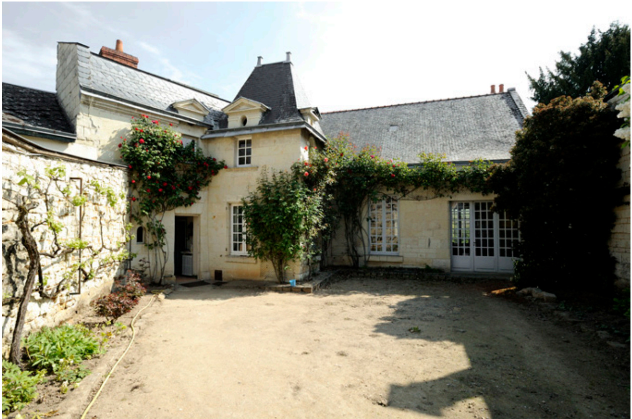
Vue générale sur la façade principale.
