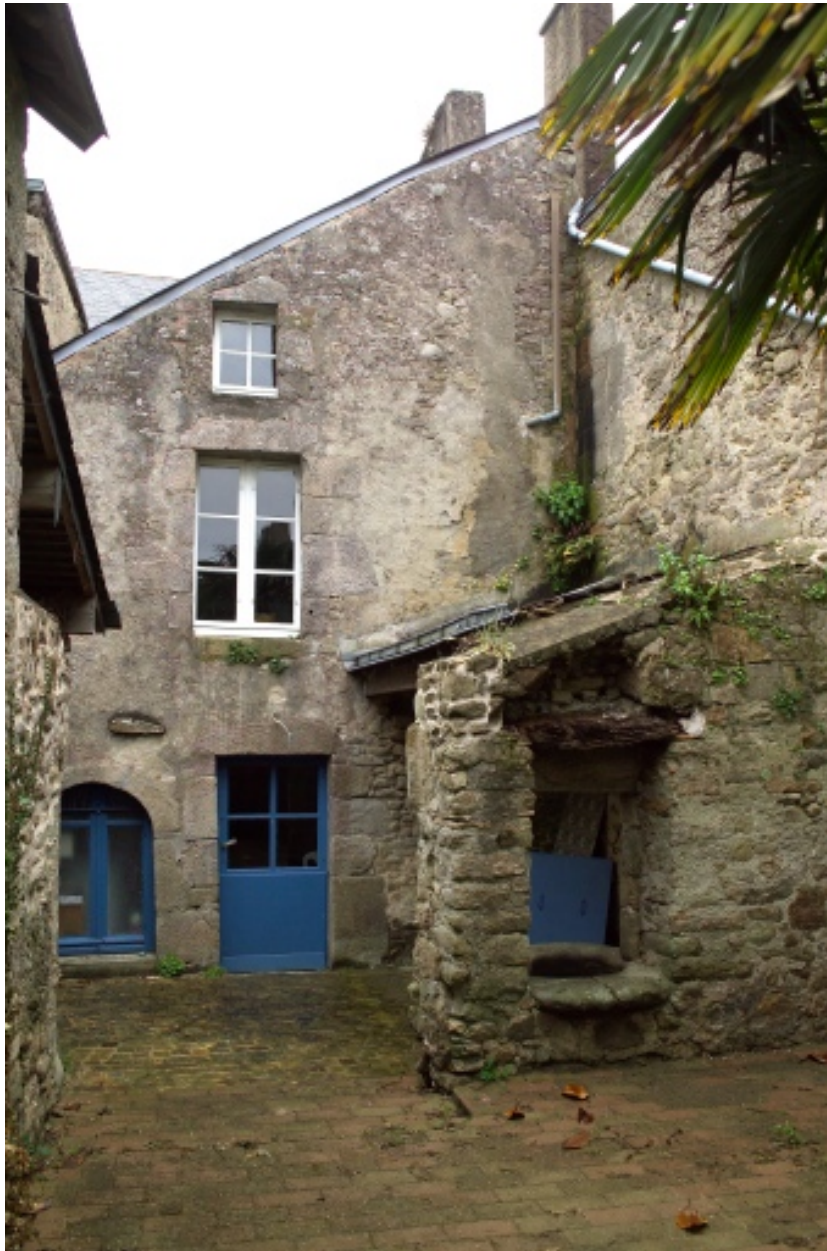
Vue de la façade arrière.
