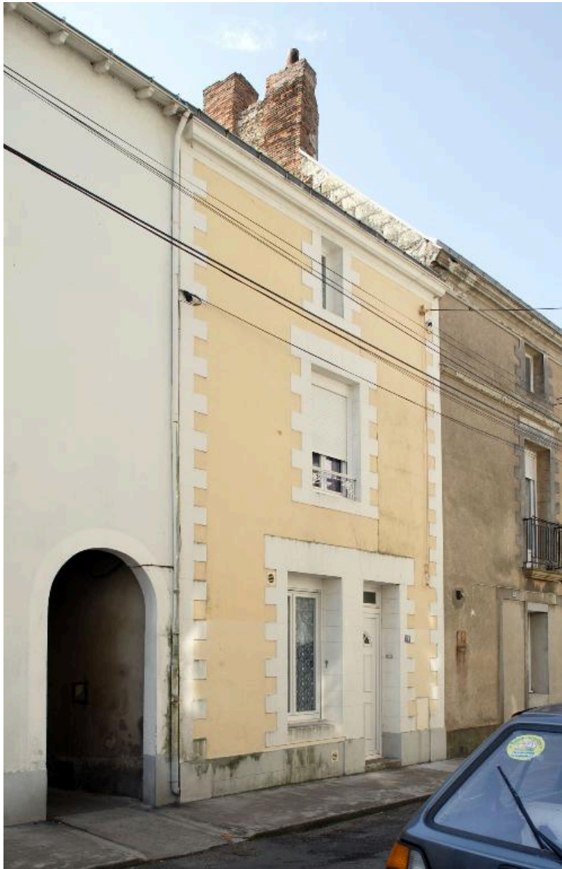
Vue de la maison n° 21 rue du Faisan, à gauche le passage d'accès à la cour.
