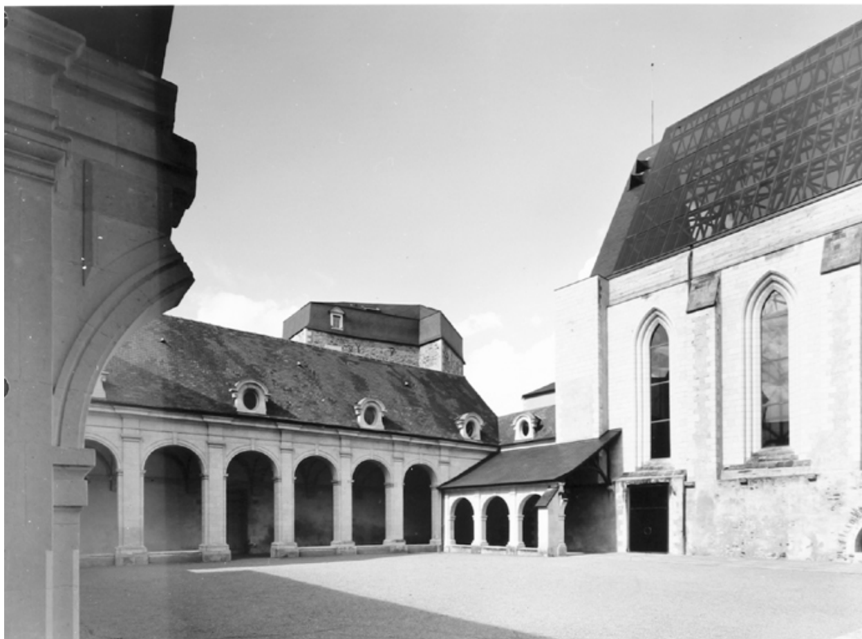
Cour du cloître : angle nord-ouest.
