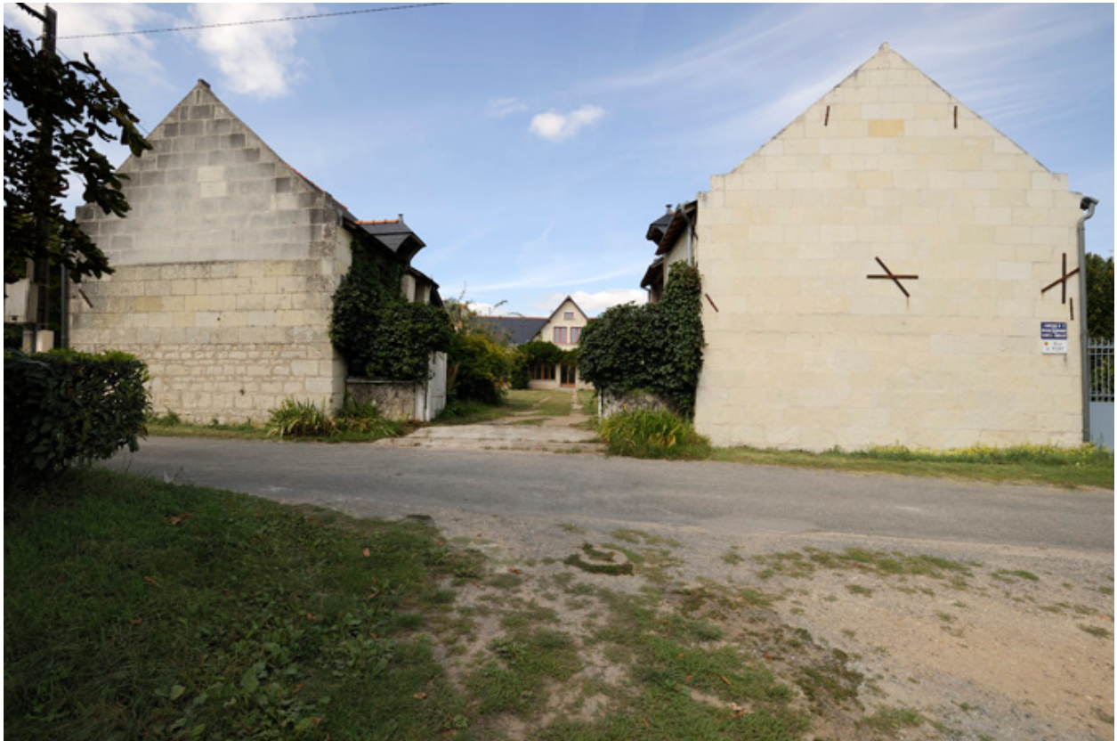
Maison du 35, rue du Port, vue depuis la rue : dépendances d'entrée et corps principal en arrière-plan.
