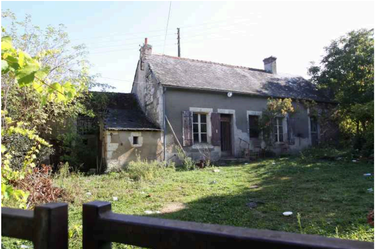
La maison n° 3 : façade antérieure sur cour.
