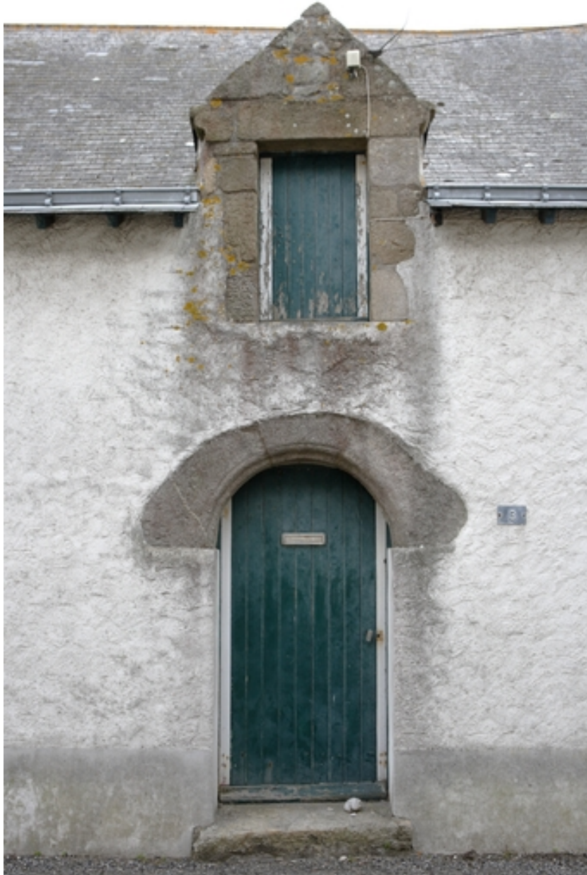
Détail de la porte et de la lucarne du n° 3 rue Courte-Baille.
