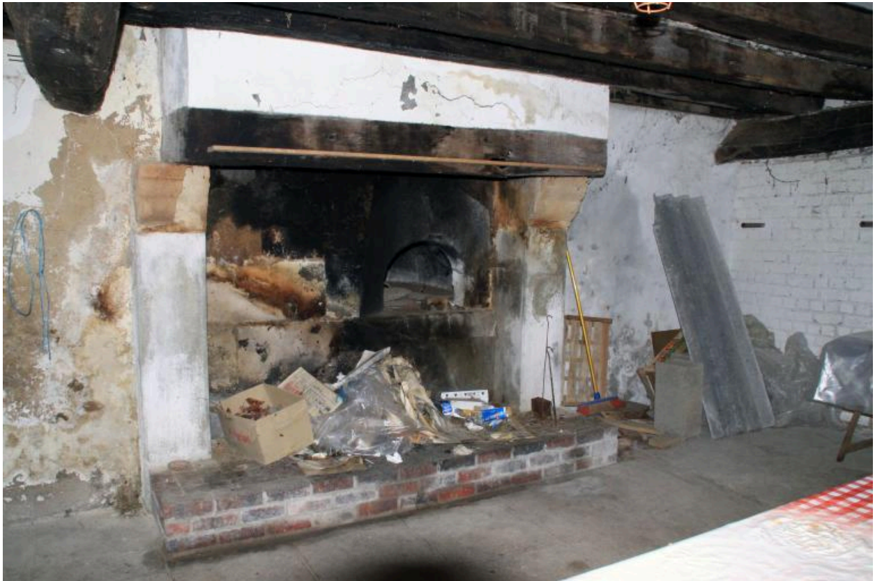
Vieille maison : cheminée sur mur goutterot remaniée.
