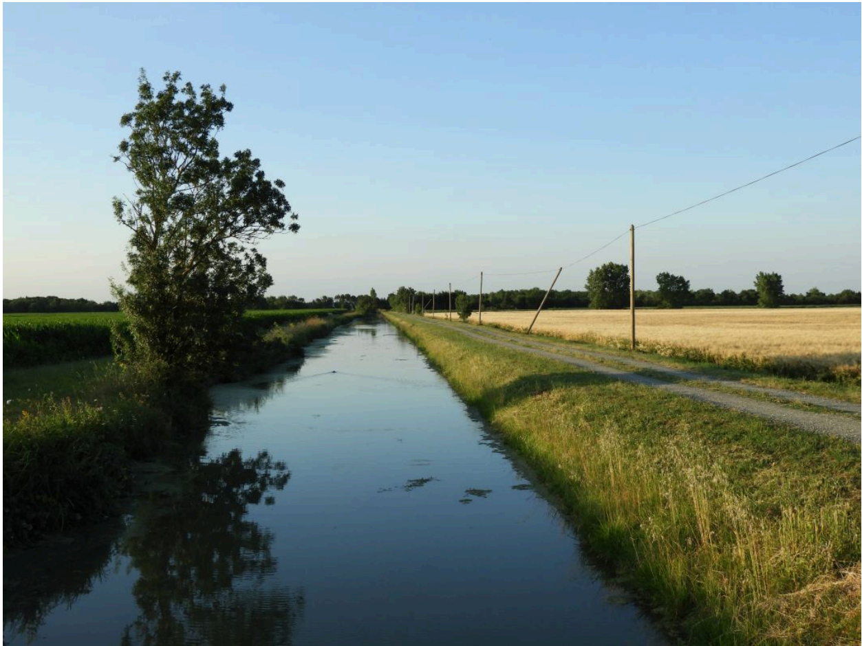
La partie amont du canal vue depuis le pont de Bois, en direction du nord-est.
