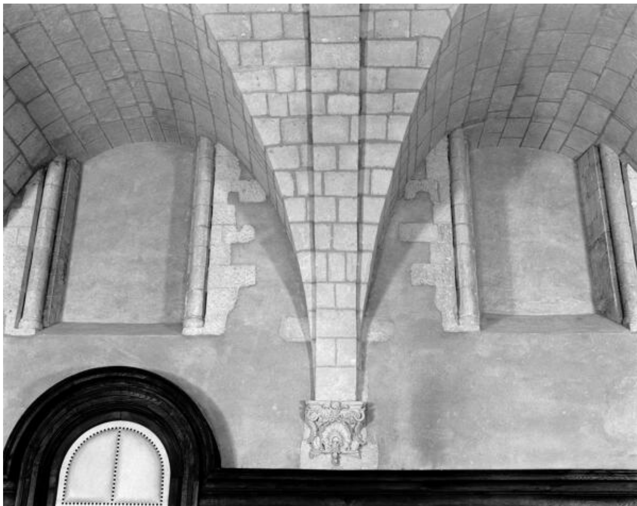
Aile sud de l'abbaye, réfectoire, élévation intérieure nord, 3e et 4e travées depuis l'est : détail sur les fenêtres-vestiges du XIIIe siècle.
