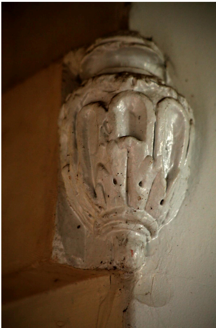
Rez-de-chaussée, voûte du vestibule : culot 4.
