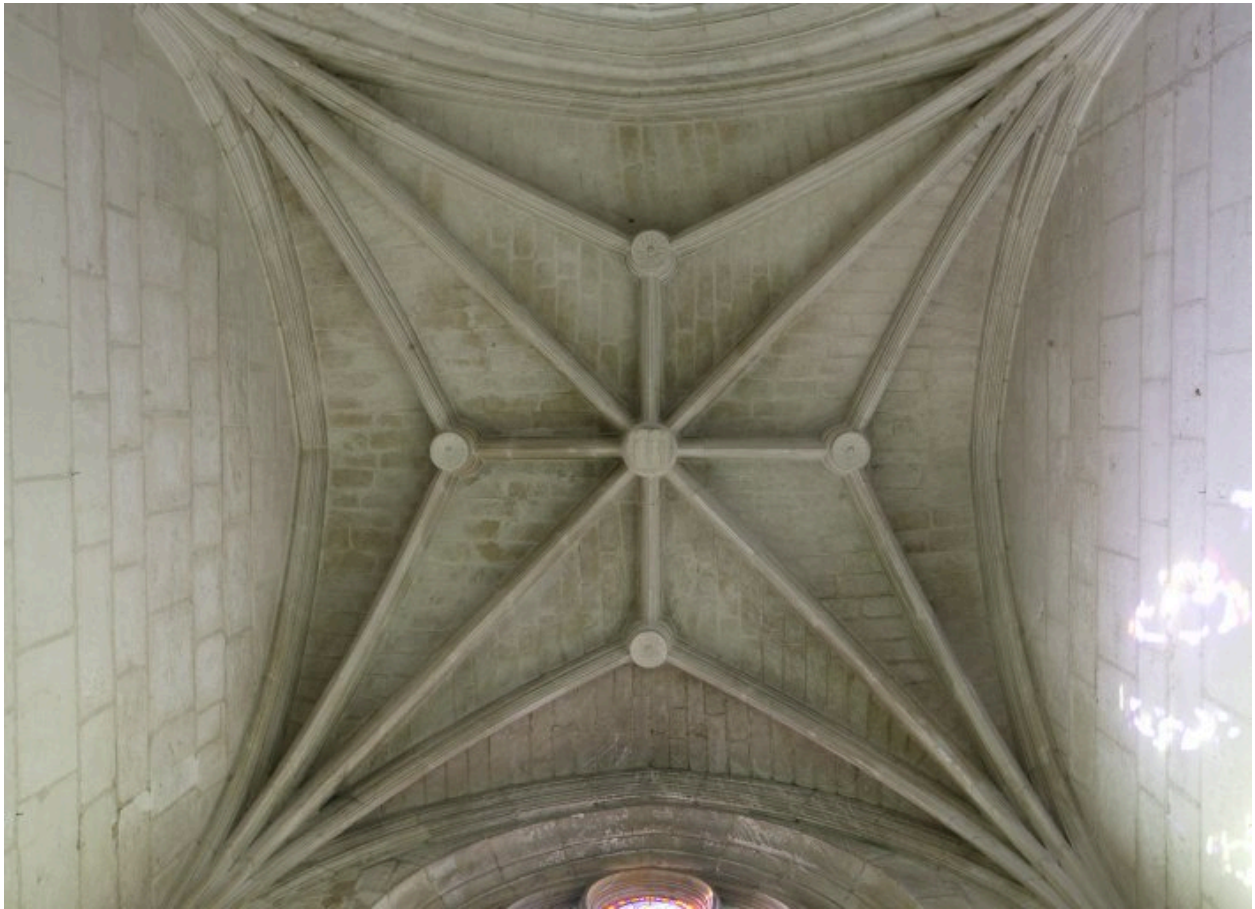
Troisième chapelle du bas-côté sud de la nef : vue de la voûte.
