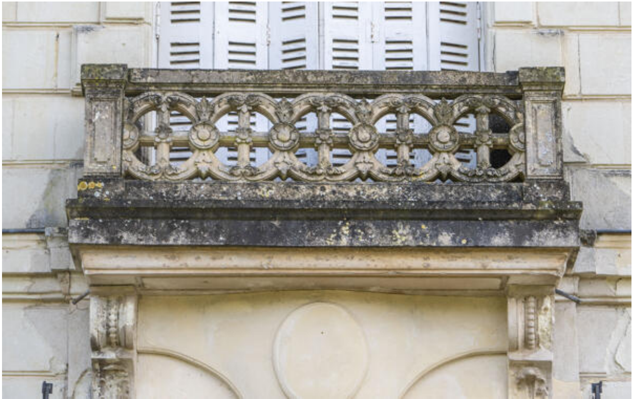
Le balcon au centre de l'élévation antérieure.
