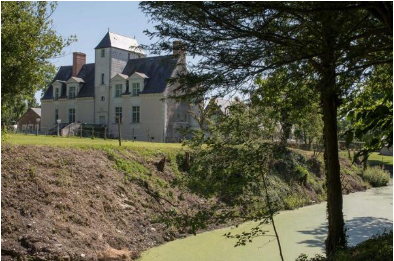
Vue de la façade postérieure.
