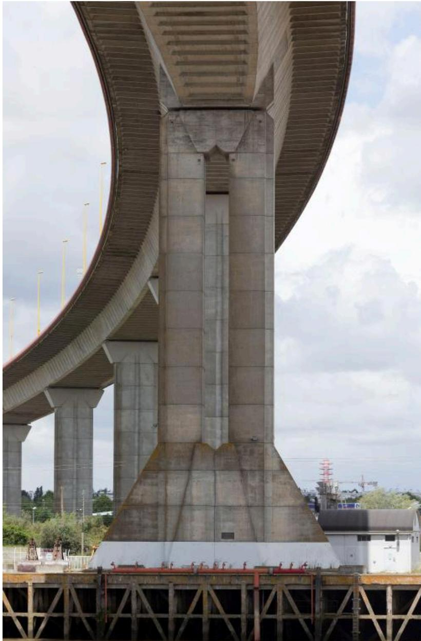
Pile principale en béton armé soutenant la travée centrale.
