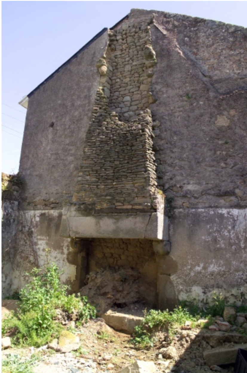
Cheminée de la partie est.
