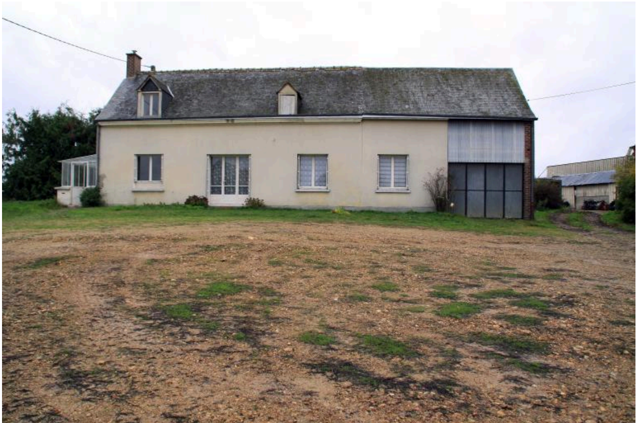
Maison de la seconde moitié du 19e siècle.
