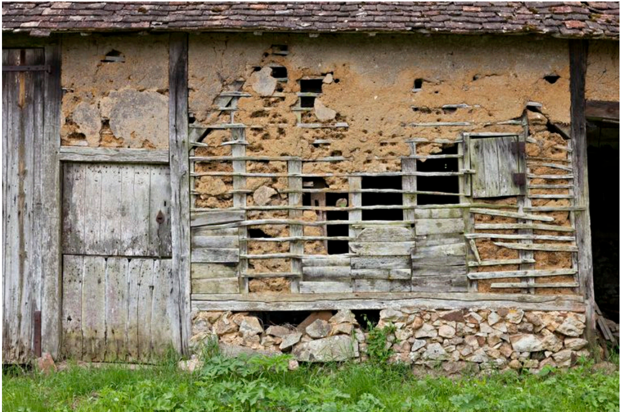
Détail de l'élévation antérieure.
