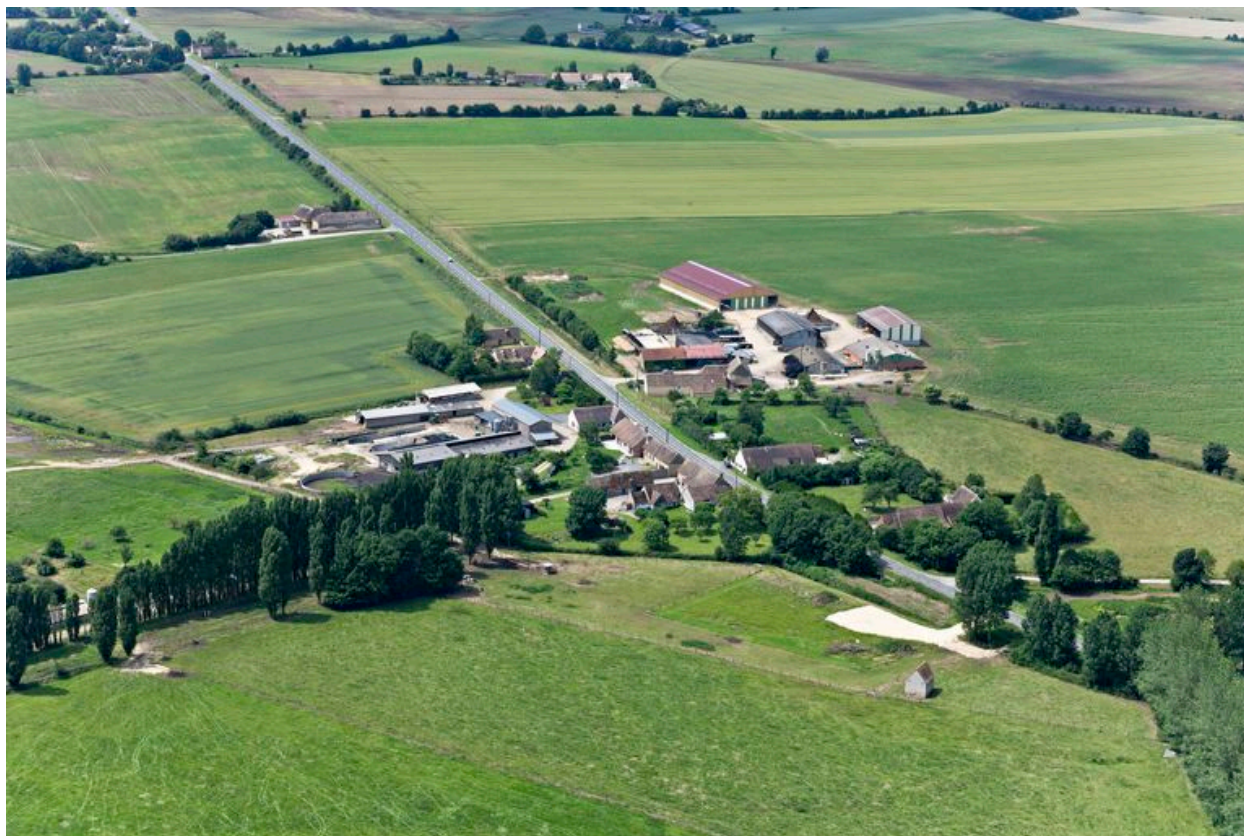
Vue aérienne depuis le nord-est.
