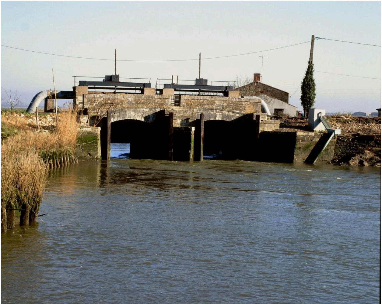
Les portes vues depuis l'aval.
