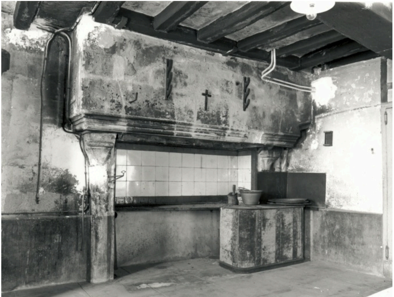
Corps de logis gauche, rez-de-chaussée, pièce antérieure, mur postérieur : cheminée.
