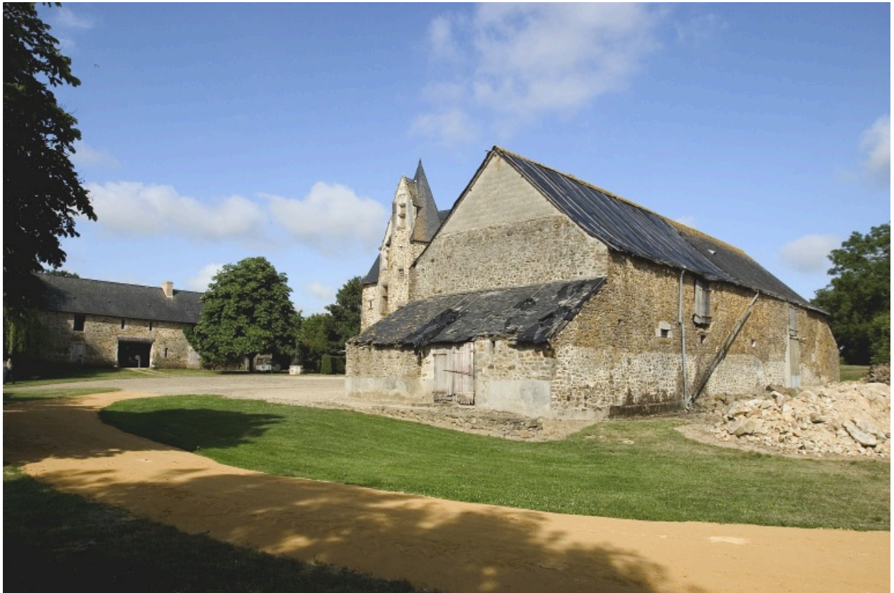
Vue d'ensemble depuis l'est : l'étable à vaches-grange, le logis, l'étable à chevaux-fournil.
