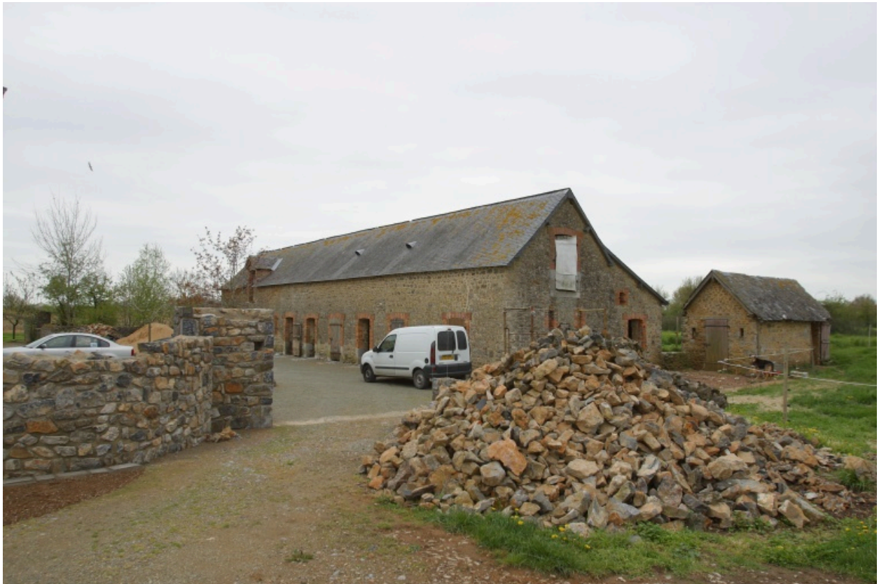
La porcherie-fournil vue depuis le nord-ouest.
